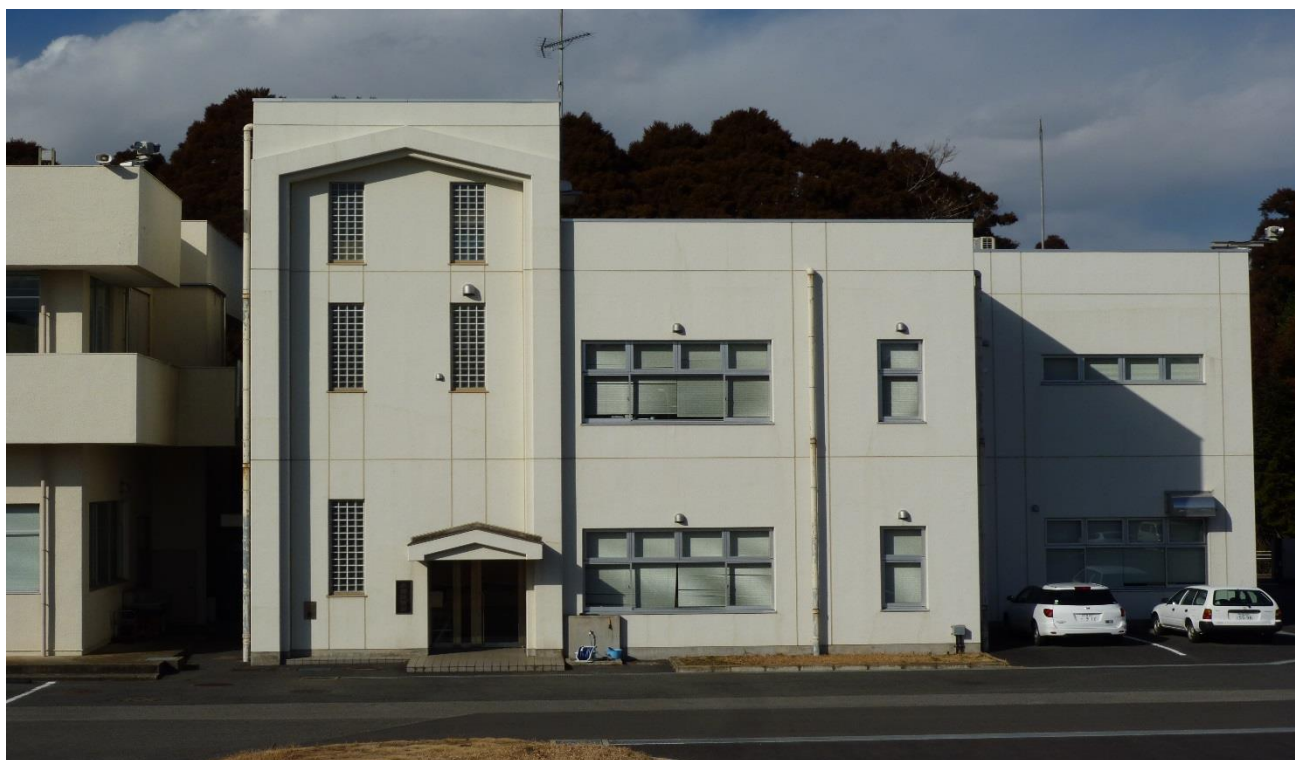
(東金浄水場内水質試験棟)
